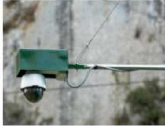
Cámara exterior AXIS P5624-E Mk II PTZ Dome colocada en el cercado 3 exterior
